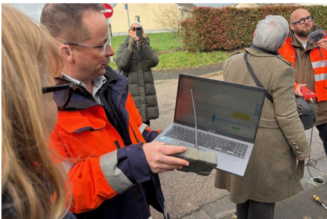
L'expérience des agents du SERPN et la technologie de Leakmited permettent d'identifier les fuites plus rapidement.
